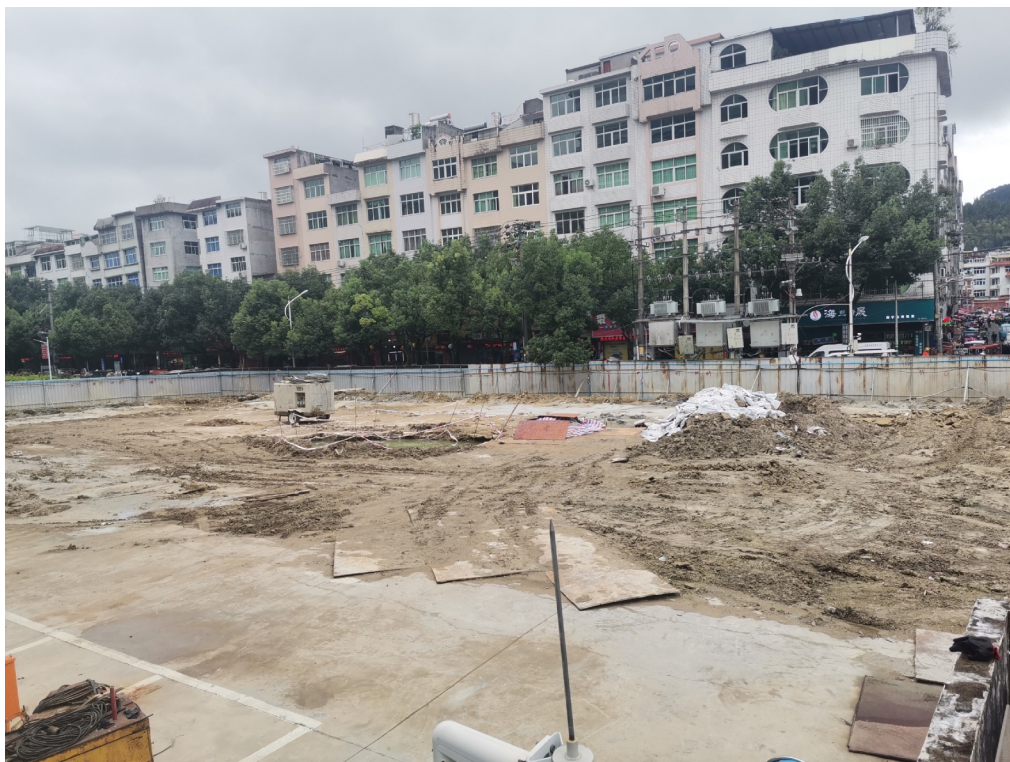
图 1.1-1 项目区现状照片
